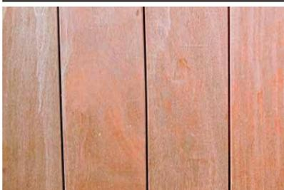
紫外線や雨などの劣化要因により、塗膜の色が褪せてしまった状態。塗装面が劣化し、木材を保護する力が弱くなっているため、塗替えが必要です。
