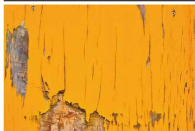
経年劣化や外的要因によって塗膜や木材の表面が剥がれてしまっている状態。木材に水が浸入することで、割れや腐食の原因となるため、早めの塗替えを推奨します。
