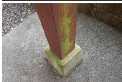
飛来した胞子が木部の表面に付着し、繁殖している状態。放っておくと水が内部に浸み込むおそれがあります。防カビ効果に優れた塗料で塗替えることで繁殖を抑制できます。
