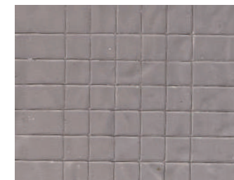
水性リガードトップワンSi 付着性が十分のため、塗膜の剥離がない
