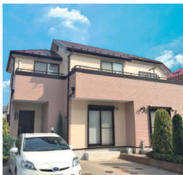
2016年施工直後の様子
