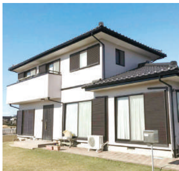
2016年施工直後の様子
